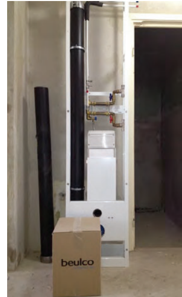
Prefabricerad våtrumskasset med tillbehör
