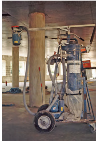
Slipning i tak – notera det integrerade utsuget
