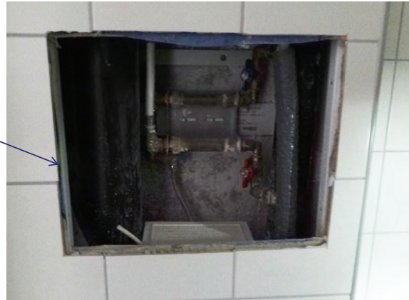
Dålig kakelsättning kring inspektionsöppning
