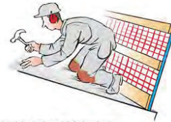
Skyddsräcke vid takarbete.
