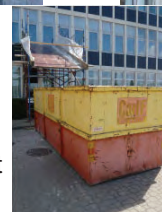
Rationell uttransport av rivningsmassor
