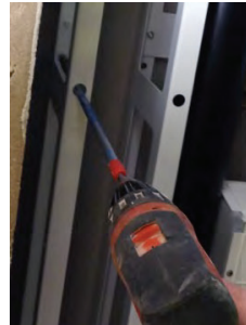
Förlängning underlättar vid montering
