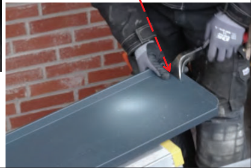
Fönsterblecket kapas i rätt dimension med en plåtsax.
