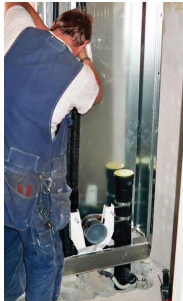
Installera avloppsstammen först
