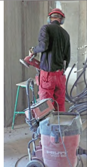
Slipning av betongväggar
