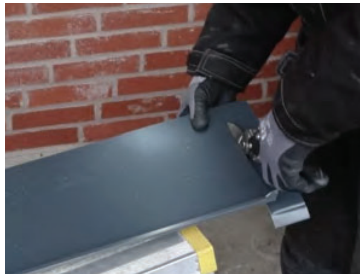
Fönsterblecket kapas i rätt dimension med en plåtsax.
