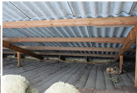
En titt in på "vinden" under eternittaket
