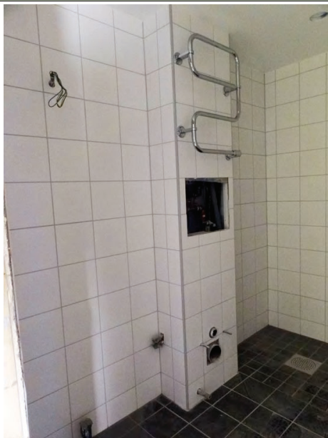
Färdigt för montering av porslin
