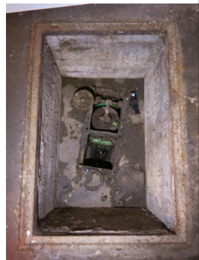
En renoverad brunn med backventil. Det gröna i bilden är epoxi-impregnerat foder.
