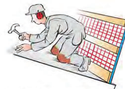
Skyddsräcke vid takarbete.
