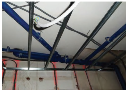
Ledningar ovan undertak
