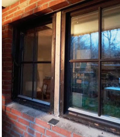
Fönster från 80-talet fästa i träreglar.
