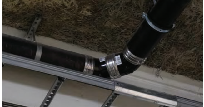
Koppling mellan nytt och befintligt
