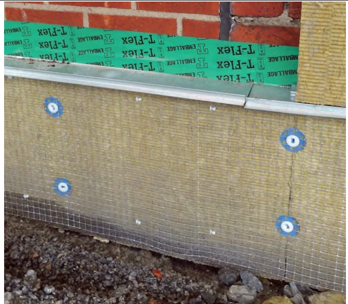
Sockel färdig för putsning.
