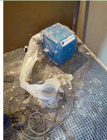
Här har en gummimatta lagts på golvet så fukten kan tas upp ur golvet och vädras ut
