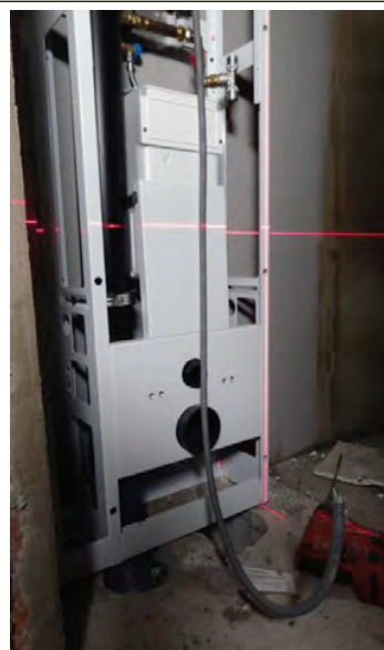
Laser kan med fördel användas
