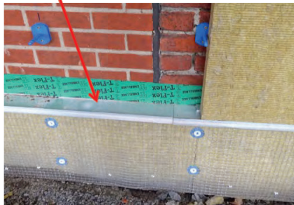
Bottenplåt med dräneringshål och fog innehållande PCB.
