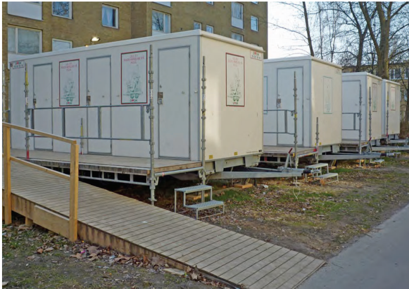
Tillfälliga WC- och duschbodrar underlättar för kvarboende
