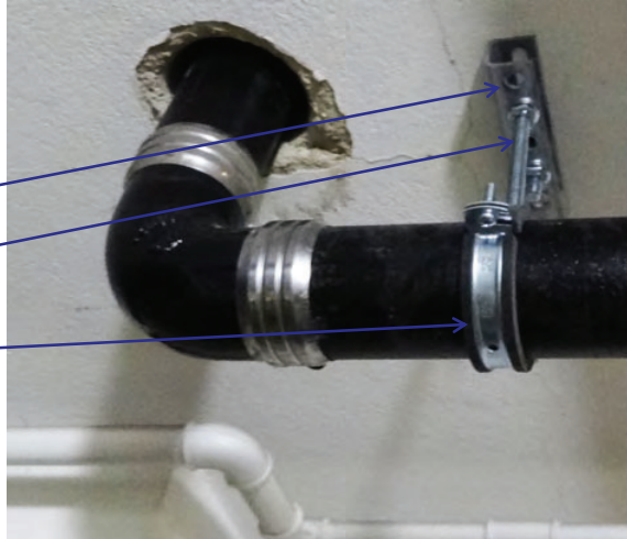
Upphängning av spillvattenledning i gjutjärn
