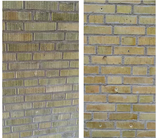
Beroende på olika förutsättningar, som typ av tegelsten och tjocklek på kramla, blir hålen mer eller mindre iögonfallande. Hålen i bilden till höger är betydligt mer framträdande än de i bilden till vänster.
