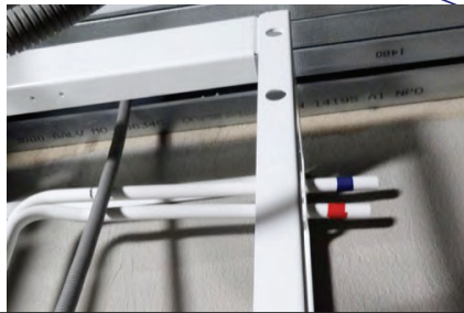
Avsättning för tappvatten till dusch
