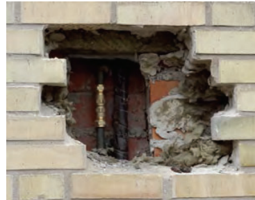
Se upp med dolda ledningar
